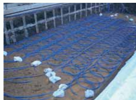
地中採熱用チューブ埋設状況
