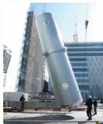
連結縦型氷蓄熱槽建設時の様子
